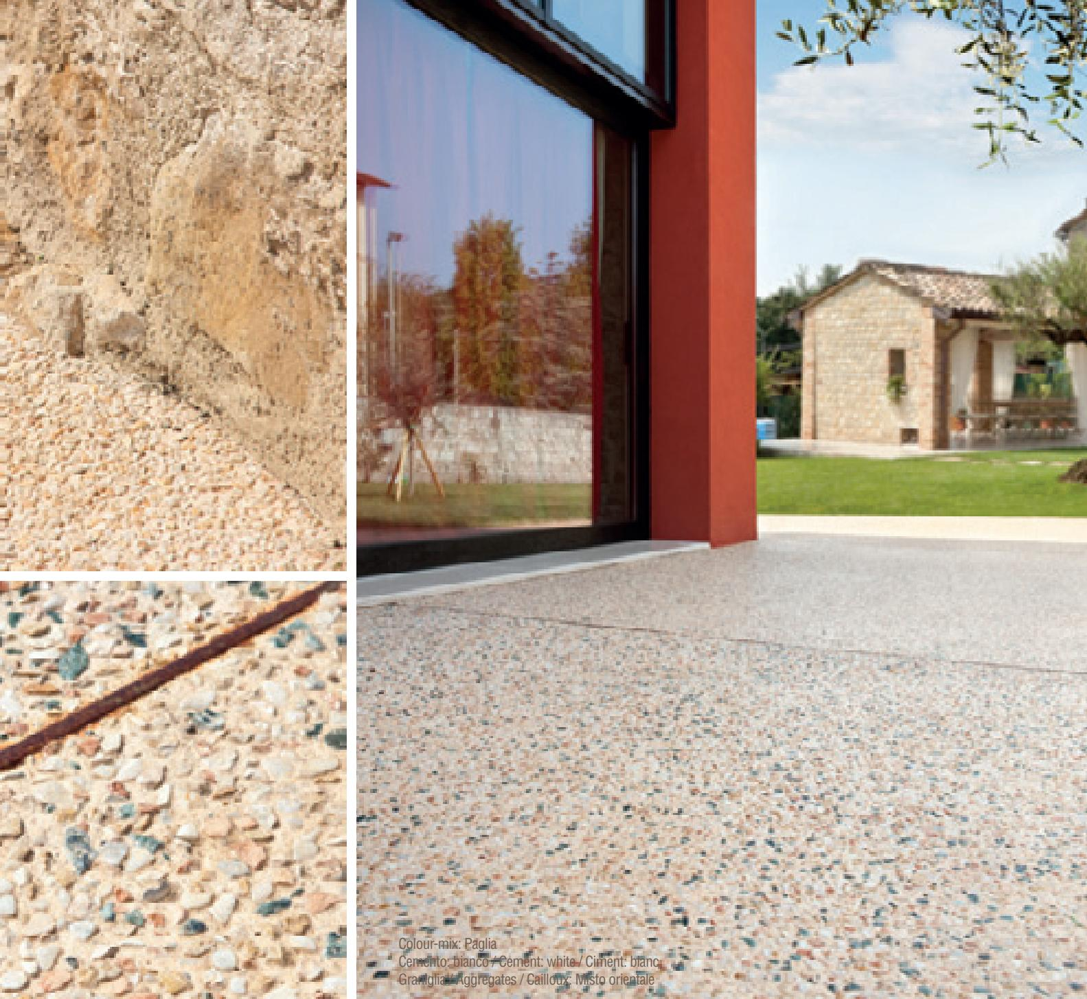
Con Sassoitalia puoi realizzare pavimentazioni nuove, direttamente sul calcestruzzo fresco, ma anche rinnovare pavimentazioni già esistenti. Sassoitalia è infatti estremamente duttile, in quanto necessita di uno spessore di soli 2 - 4 cm sopra il calcestruzzo esistente. Per una bellezza di lunga durata, la superficie può essere trattata con speciali resine protettive, antipolvere e antiassorbimento.
